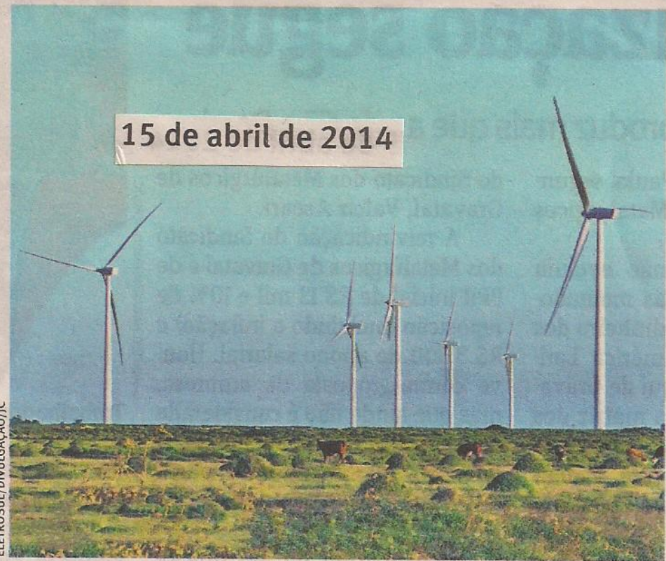
Aerogeradores já giram em Santa Vitória do Palmar
